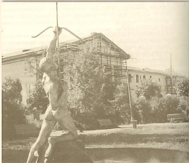
Здание строящегося Драмтеатра, вид со стороны Городского сада
