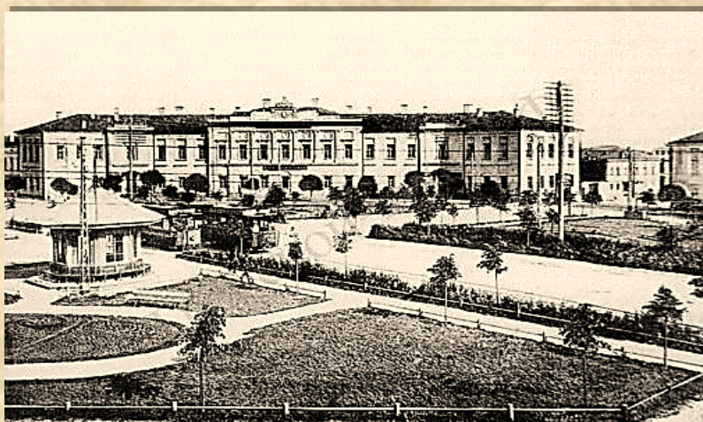
1900-е гг. Тверь. Судебная площадь. Здание Казённой палаты. Пожарная каланча на ул. Миллионной (в левом верхнем углу).
